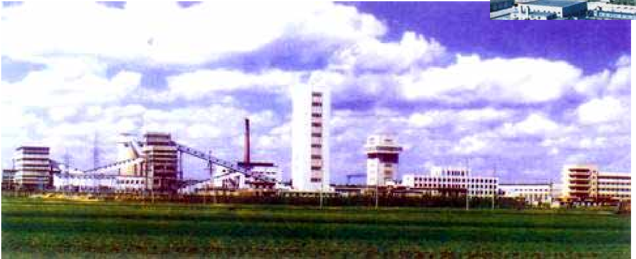
Tiefa Santaizi Mine No. 1, Liaoning
