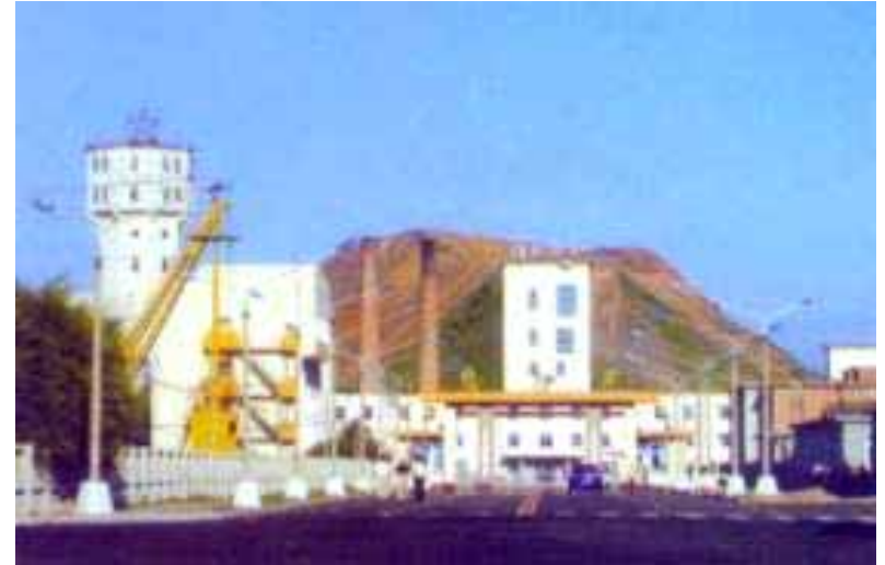
Tiefa Xiaonan Mine, Liaoning
